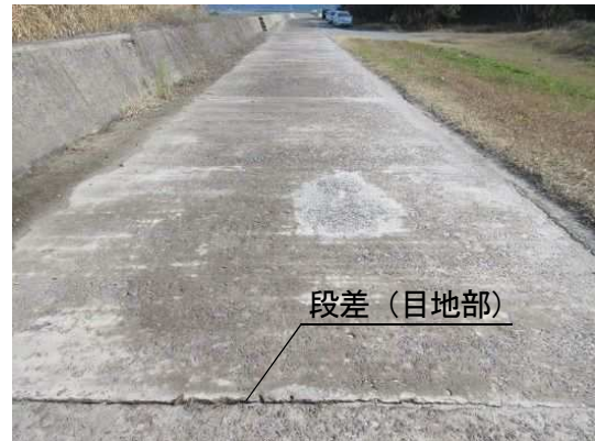
図Ⅱ-24 海岸管理道コンクリート舗装
