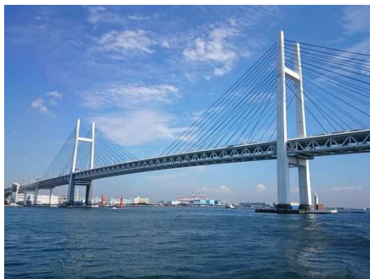
図Ⅲ-20 横浜ベイブリッジ
