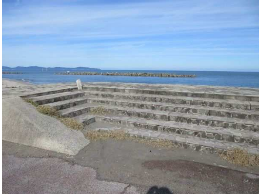
図Ⅲ-16 緩傾斜護岸
