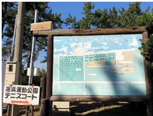
図Ⅲ-9 位置図看板(修繕が必要)
