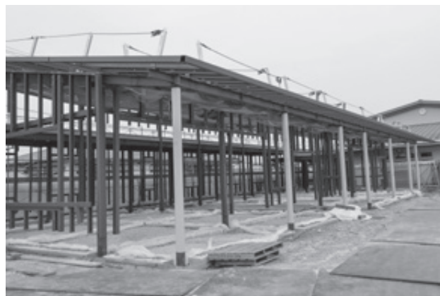
▲保育室の増設工事中（6月時点）
