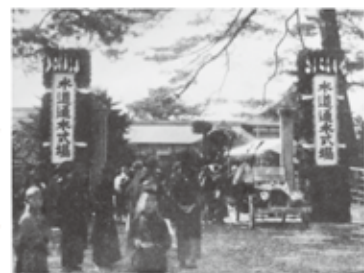
湊山公園で行われた水道通水式
